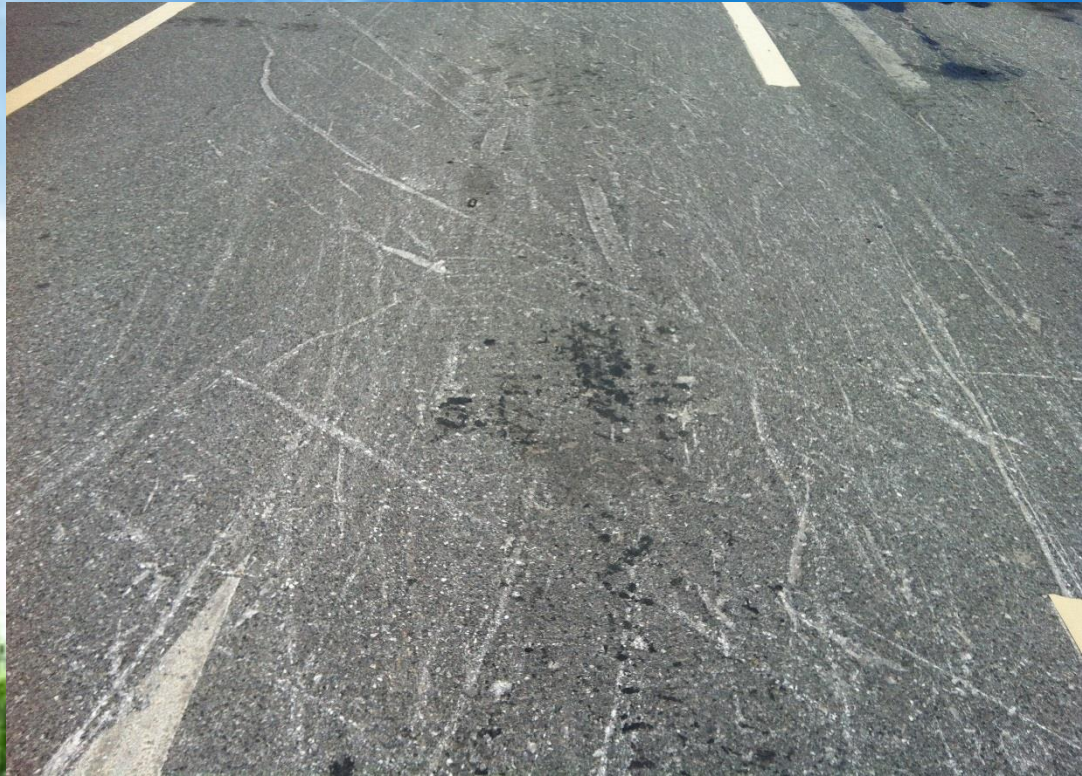
施工前路面（局部）
