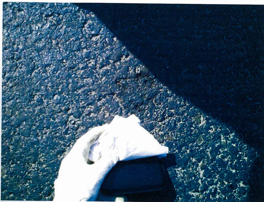
附图 3 汽油渗入原有沥青路面
