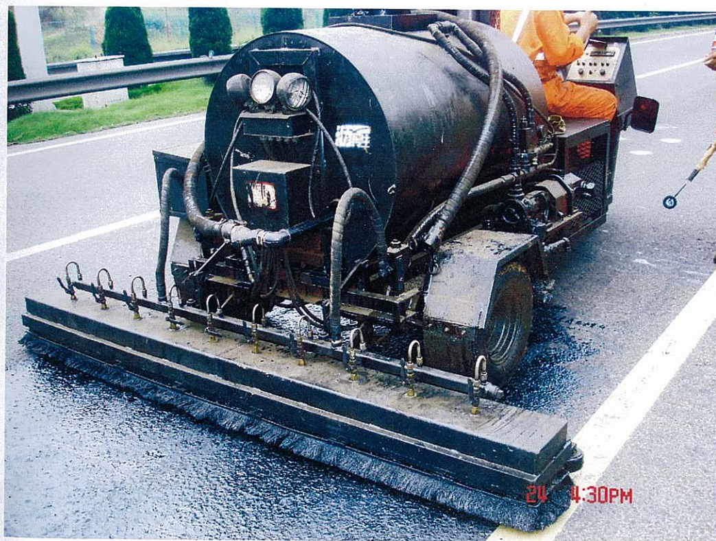
附图 6 [沥青再生]施工快速、简易
