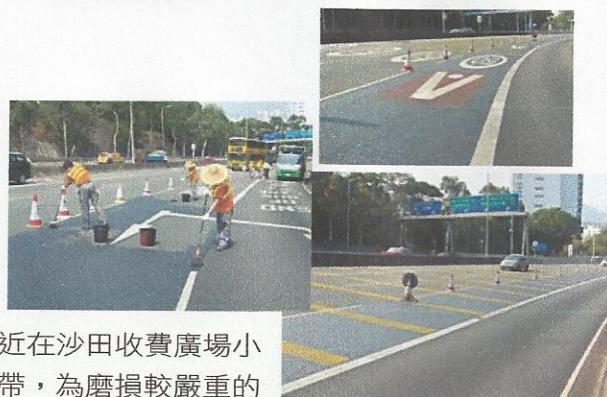
同時我們最近在沙田收費廣場小瀝源入口一帶，為磨損較嚴重的瀝青路面塗上了一種名為瀝青再生密封劑的瀝青油，採用了這種瀝青油後，大大延長了路面的使用壽命從而減少了其護養的周期成本，同時亦避免了因重鋪路面而對隧道交通的影響和駕駛者帶來的不便。
